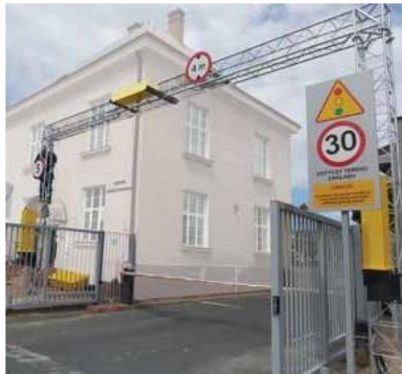
System PI-MSKA z detektorem górnym i dwoma detektorami umieszczonymi naprzeciwko siebie
