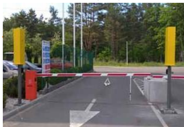
System PI-MSKA z dwoma detektorami umieszczonymi naprzeciwko siebie
