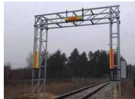
System kolejowy PI-MSKA z detektorem górnym i dwoma detektorami umieszczonymi naprzeciwko siebie
