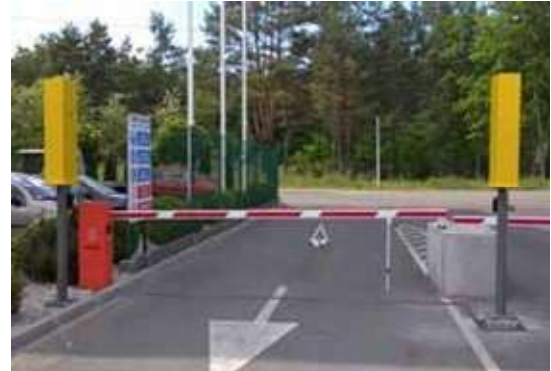
System PI-MSKA z dwoma detektorami umieszczonymi naprzeciwko siebie
